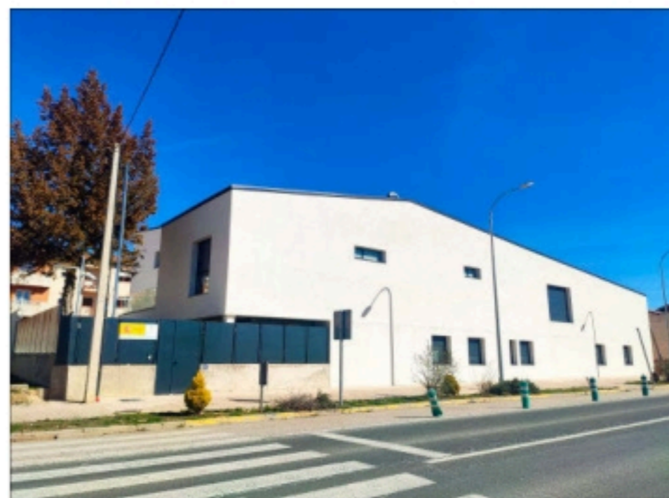
Nueva casa cuartel de la Guardia Civil en San Esteban. ANA HERNANDO
