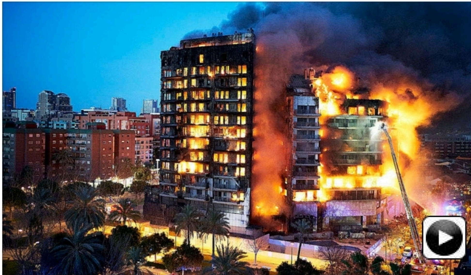
Imagen general del edificio devorado, ayer, por las llamas en Valencia mientras los bomberos tratan de sofocar el fuego. M. QUEIMADELOS / GETTY
