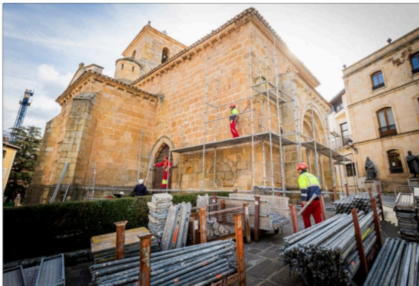
Los operarios se afanaban ayer en la colocación de los andamios en San Juan de Rabanera. MARIO TEJEDOR
